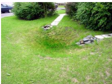
Versickerungsanlagen mit Überlauf 0,1
